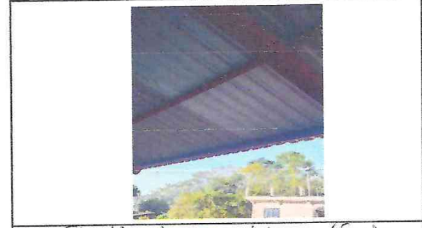
Foto 4: Finalización cambio de láminas y costanera
