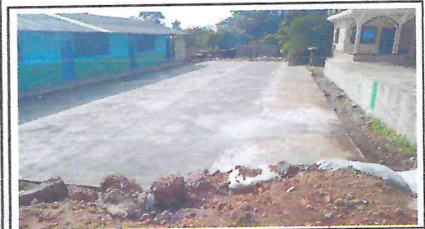
Foto 3: Finalización de mejoramiento Lora de patio
