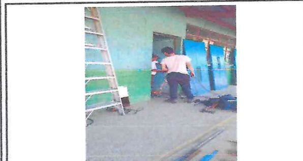
Foto 3: Mantenimiento de puertas
