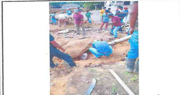
Foto 1: Mejoramiento de loza de patio
