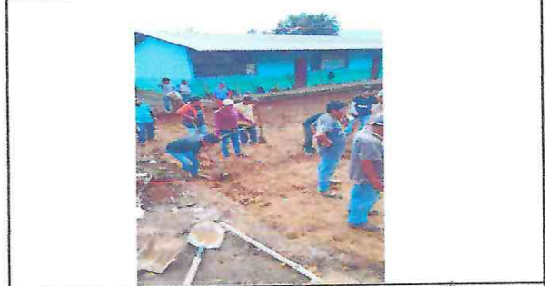
Foto 2: Mejoramiento de loza de patio
