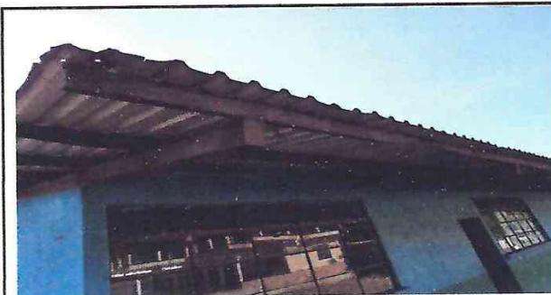
FOTO 3: LAMINA DETERIORADA Y COSTANERA
