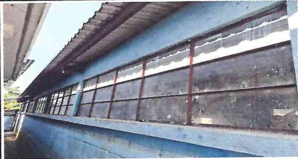
FOTO 1: PINTURA DEL MODULO EN MAL ESTADO, VENTANAS SIN BALCONES
