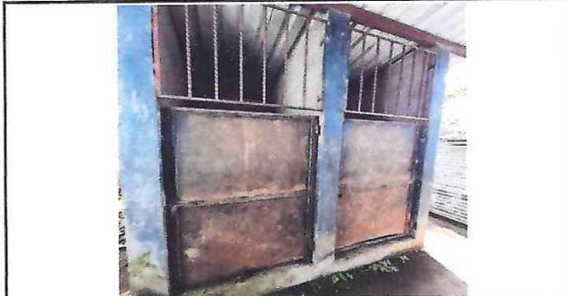
FOTO 4: PUERTAS, PINTURA DETERIORADAS
