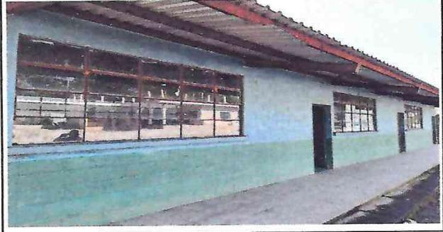
FOTO 2: PINTURA DEL MODULO EN MAL ESTADO, VENTANAS SIN BALCONES
