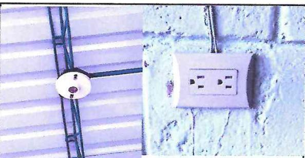
Foto 6: Sustitucion de flaponera y toma corriente reparado finalizado
