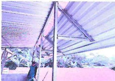
FOTO 1: INSTALACION DE LAMINAS, MALLA, COSTANERA EN EL PERIMETRO DE LA COCINA
