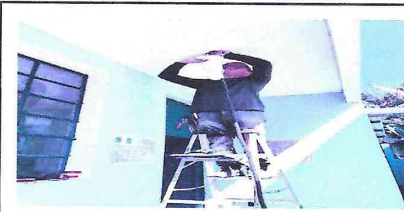
Foto 5: Sustitucion de flaponera y lampara quemada
