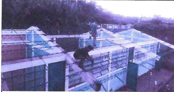
Foto 1: Aplicación de pintura en estructura de yoys
