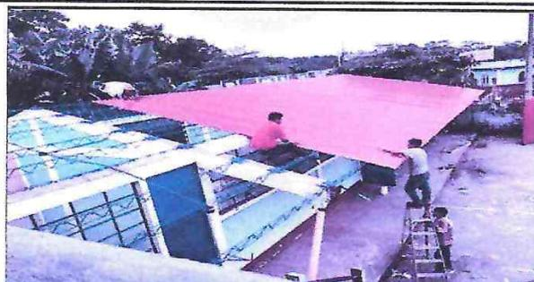
Foto 2: Montaje de cubierto de lamina de modulos
