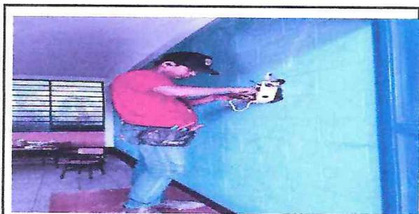
Foto 6: Sustitucion de centro de carga 2 polos y flipones de 30 amp
