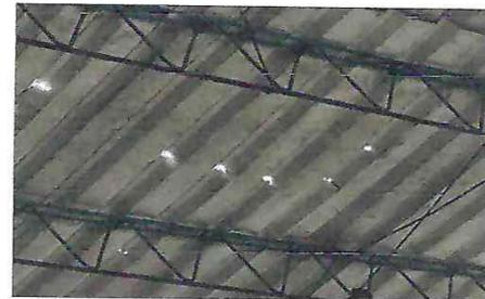
FOTO 10: LÁMINAS DETERIORADAS
