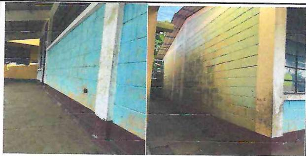
Foto 5: Pintura del inverso perimetral deteriorada
