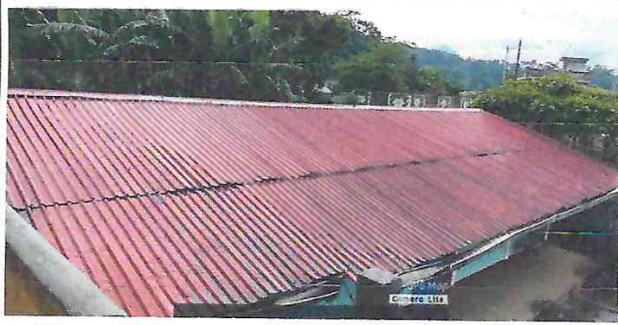
Foto: Laminas deterioradas con fugas de lluvia
