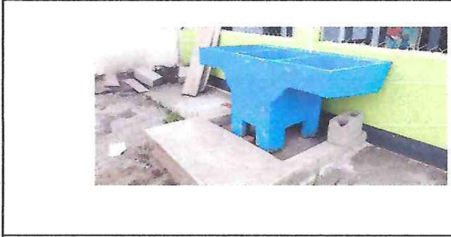
Foto 5: Culminacion de la colocacion de la pila con su drenaje y agua potable.
