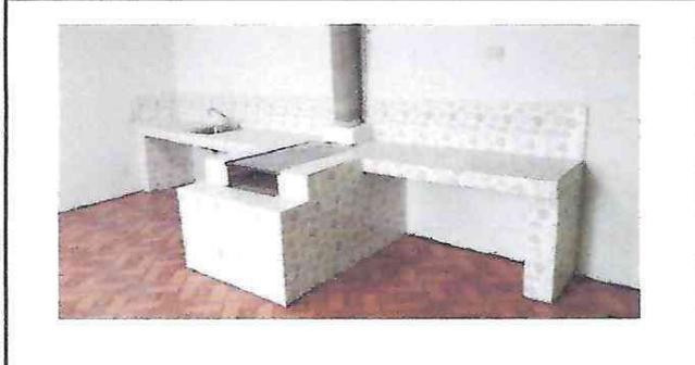
Foto 2: Culminacion de reconstruccion y ampliacion de estufa artesanal adecuando sus dimensiones para su correcta utilizacion.
