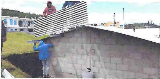
Foto 1: Reparación y cambio de techo de cocina
