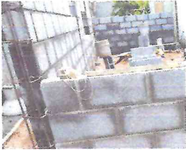
Obra no terminada
