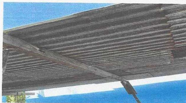
Foto 2. Cubierta de lamina deteriorada
