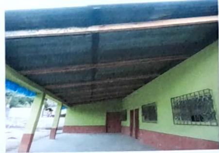
Foto 2: Sustitucion de tendales de madera por costaneras galvanizadas
