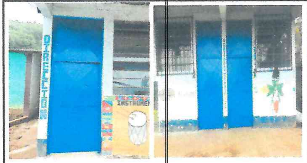
Foto 4: Reparación y pintada de puertas terminada
