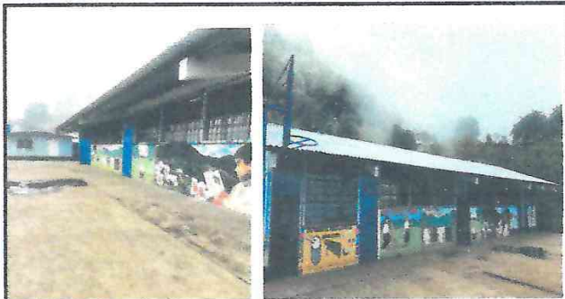
Foto 1: Reparación e instalación de techo terminado
