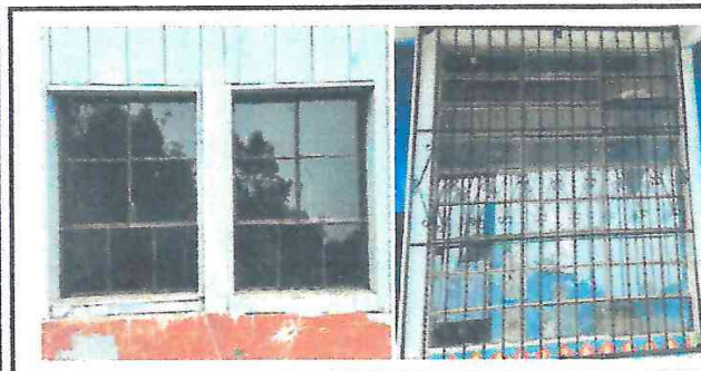
Foto 5: Reparación e instalación de vidrios terminada
