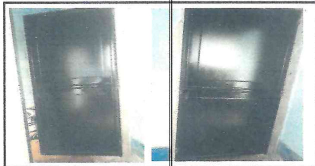
Foto 6: Implementación de Puerta de Dirección terminada
