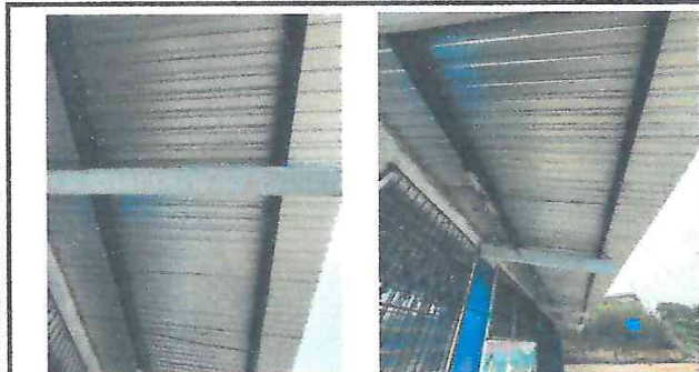
Foto 3: Reparación de costaneras terminada
