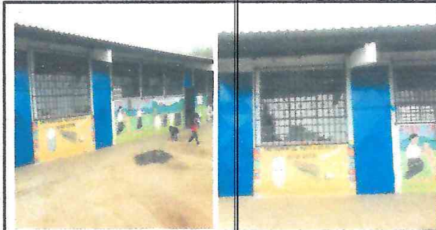
Foto 2: Implementación de Balcones terminado
