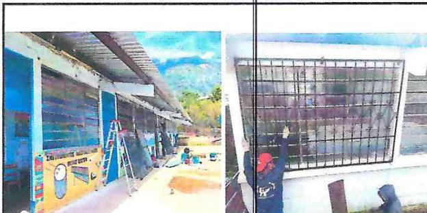
Foto 2: Instalación de Balcones en las ventanas.
