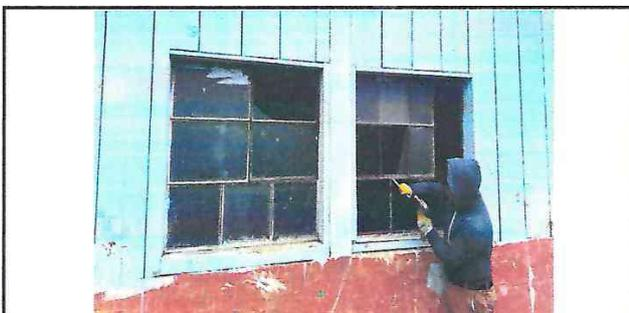
Foto 5: Reparación y cambio de vidrios quebradas
