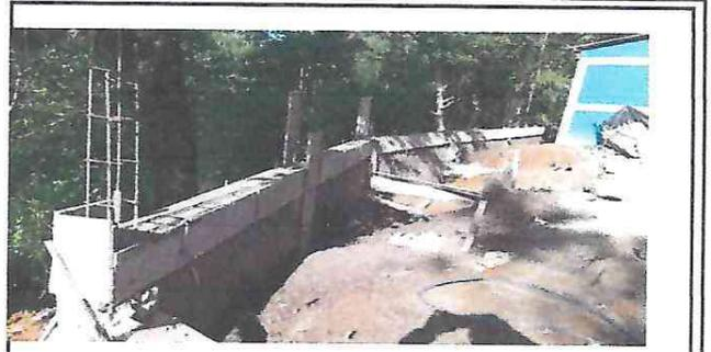
Foto 2 Reparación de muro de contención
