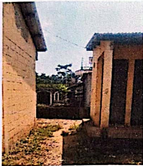
ESPACIO DISPONIBLE PARA INSTALAR DOS SANITARIOS
