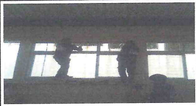
Colocacion de las ventanas
