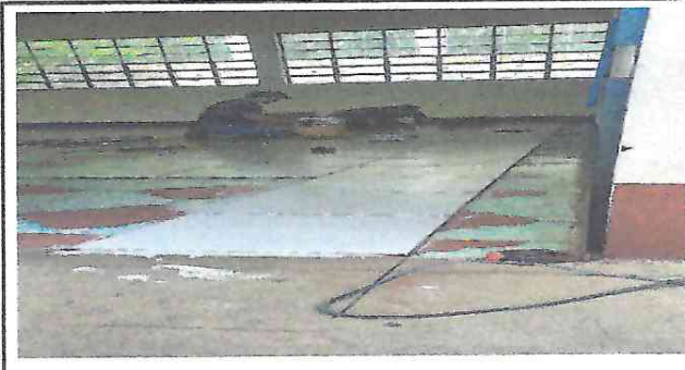
Colocación de pisos Cerámica en las aulas
