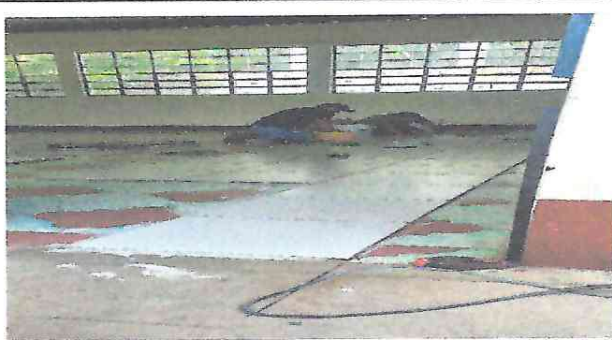
Colocación de pisos cerámica en las aulas
