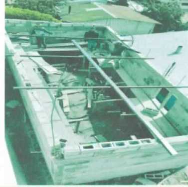
Foto 2: colocación de costaneras
