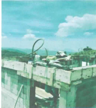
Foto 1: fundición de la corona de la bodega.
