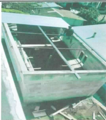
foto 3: colocación de láminas
