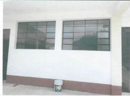
Foto 2: No cuenta con balcones
