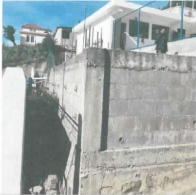
Foto 1: Obra no terminada , colocación de puertas, ventanas y piso
