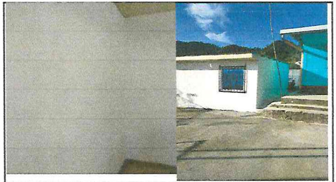
Foto 4 : repello interior y exterior de la cocina .
