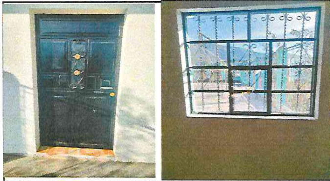
Foto 7: Puerta y ventanas instaladas
