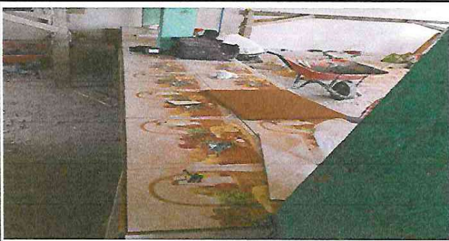
Foto 3: mesa de comedor de concreto, en proceso de colocación
