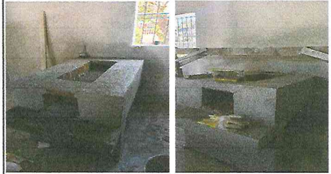
Foto 2: Plancha de cocina, en proceso de construcción
