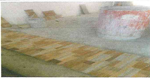
Foto 1: Piso de cocina, en proceso de instalación
