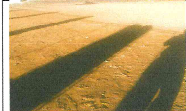
Foto 8 : losa de patio de la escuela, en proceso de Construcción
