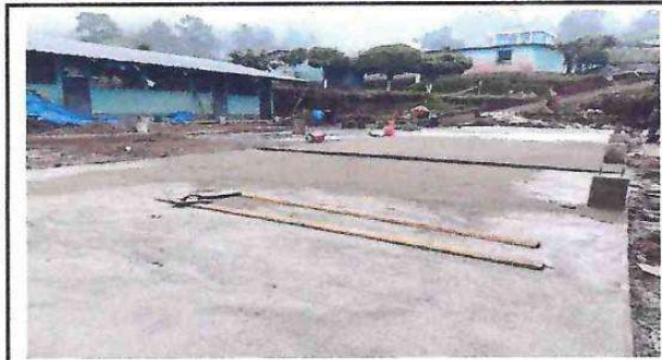
Foto 1: Losa de patio
