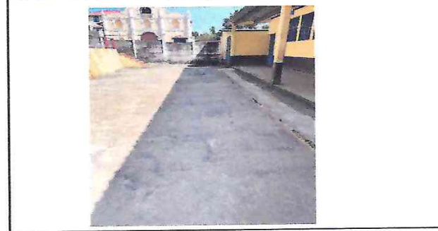
Foto 4: Reparación finalizada de la fosa ceptica sin aguas negras
