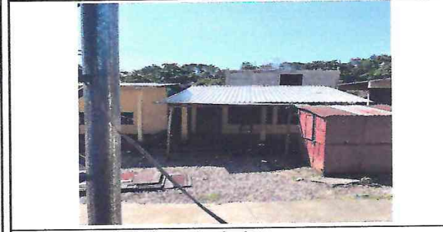
Foto 5: Reparación de láminas terminadas
