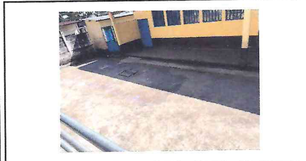
Foto 3: Reparación finalizada de la fosa ceptica
