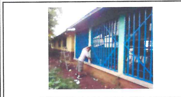
Foto 3 Colocacion de Balcones.
