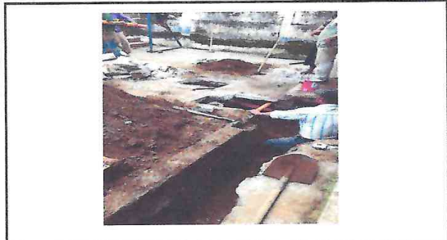
Foto1. Sustitucion de Tuberia de la red de drenaje.
