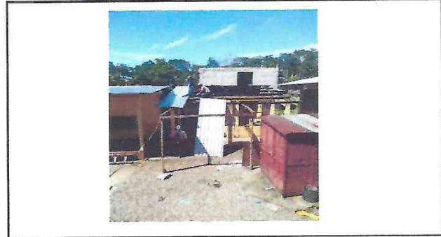
Foto 4. Sustitucion de Laminas Deterioradas.
