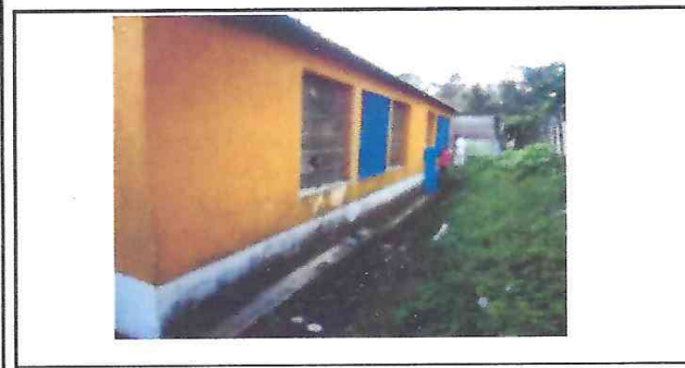
Foto 5: Colocacion de Balcones.
