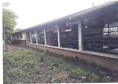
FOTO 2: VENTANAS SIN BALCONES
