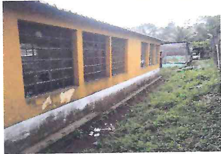
FOTO 1: VENTANAS SIN BALCONES
