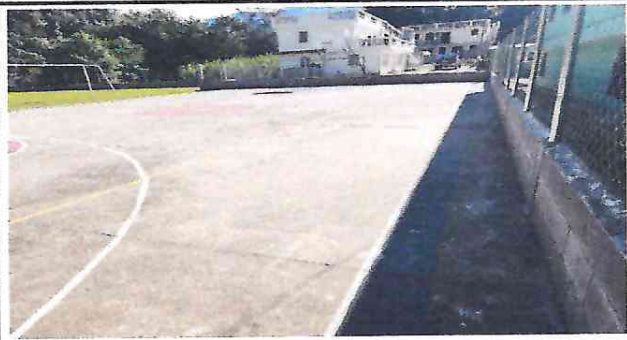
Foto 1: Culminación del muro perimetral.
