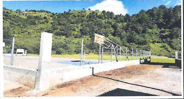
Foto 2: Culminación del muro perimetral.
