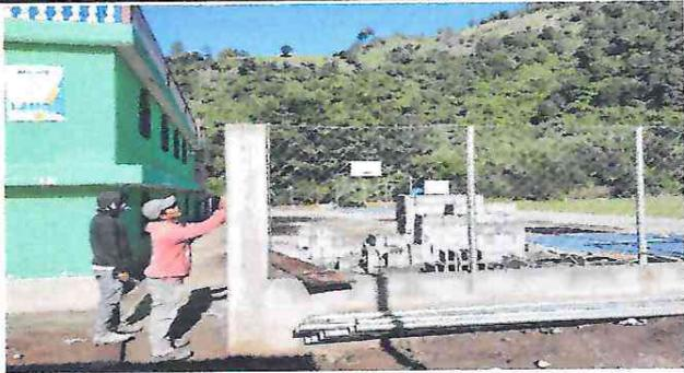
Foto 1: Fundación de columna del muro perimetral.
