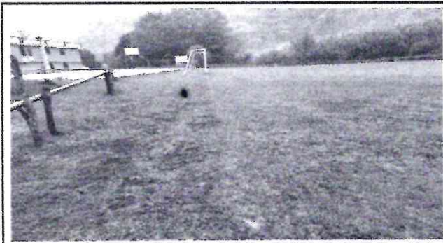
Foto 1: Falta de muro perimetral
