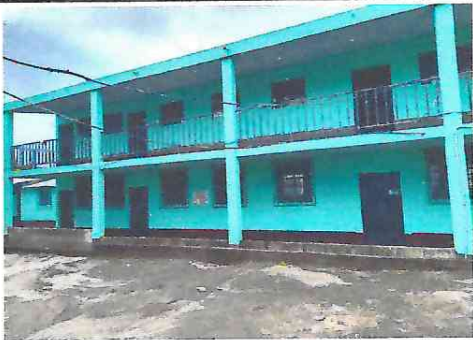
Mantenimiento de red eléctrica
