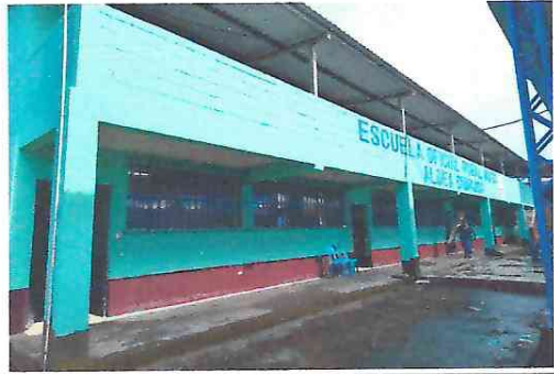
Aplicación de pintura en muros exteriores
