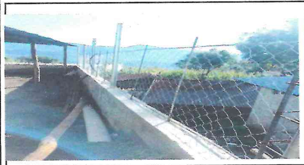
Foto 3: Reparación de muro y colocación de malla galvanizada
