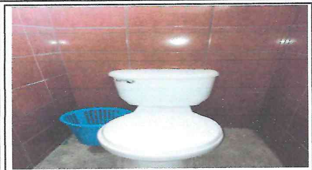
Foto 1: Sustitución de inodoro y accesorios.
