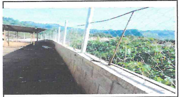
Foto 2: Reparación de muro perimetral y colocación de malla galvanizada
