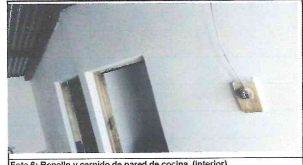
Foto 6: Repello y cernido de pared de cocina. (interior)
