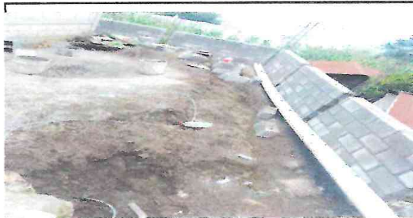
Foto 3: Reparación de muro y colocación de malla galvanizada
