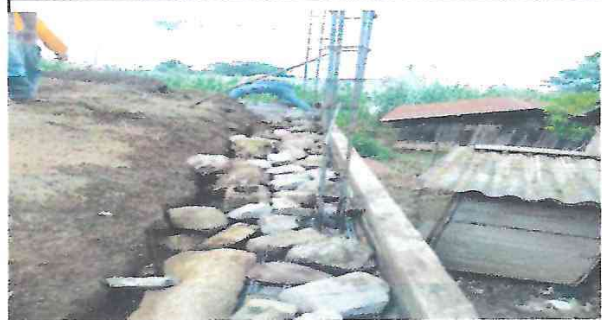
Foto 2: Reparación de muro perimetral y colocación de malla galvanizada
