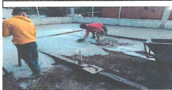
Foto 4: Plancha de concreto de patio. Area de juego para alumnado.
