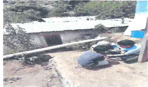
Foto 2: Reparación de muro perimetral y colocación de malla galvanizada.
