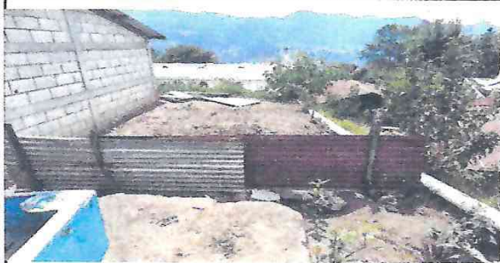
Foto 2. reparación de muro perimetra y colocación de malla calvanizada.
