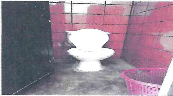
Foto 1. Sustitución de inodoro y accesorio (inodoro para niños de preprimaria)
