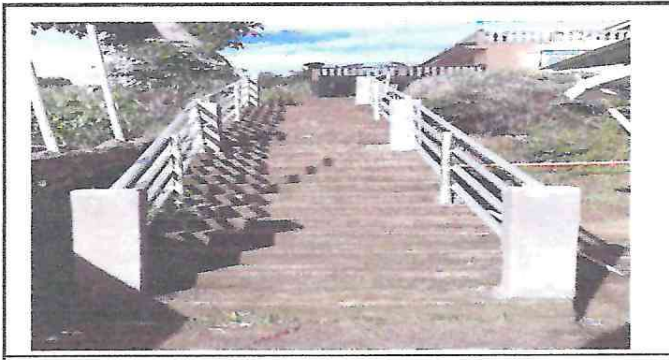
Foto 5: Gradas con barrandas nuevas
