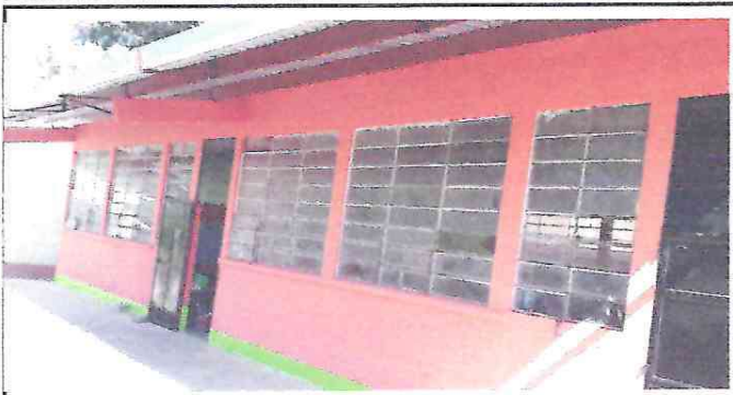
Foto 1: Instalación de canales, techos, vidrios y pintada de aulas.
