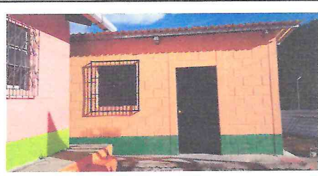
Foto 2: La cocina con su nuevo techo, balcon y pintada
