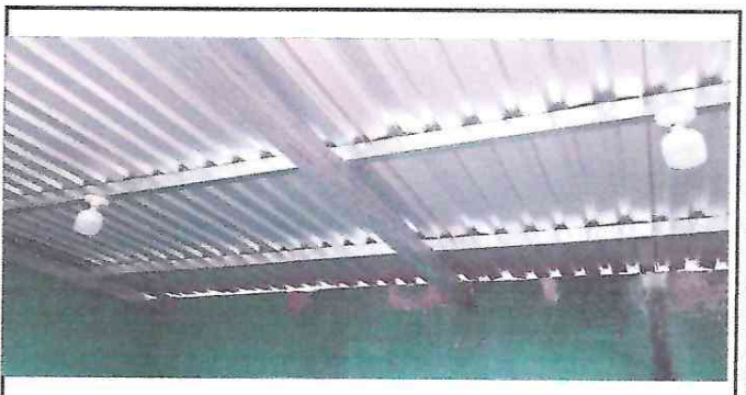
Foto 4: Instalación de costaneras, láminas y focos
