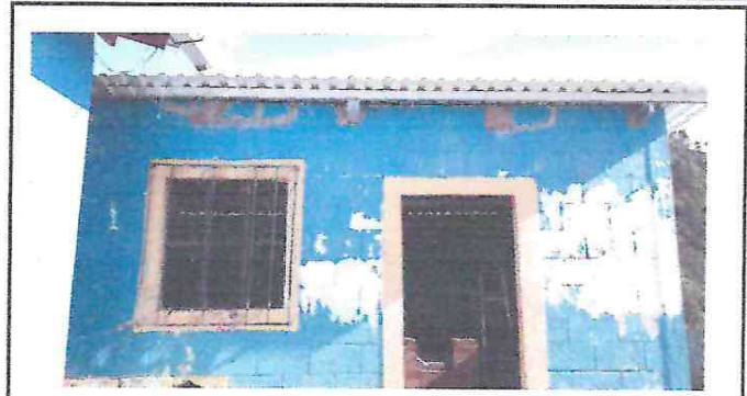
Foto 2: Cambios de techado y reparación de estufas en la cocina
