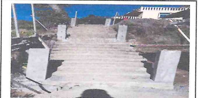
Foto 5: colocación de columnas de concreto para barrandas
