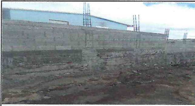
Foto 1 Muro de contención terminado
