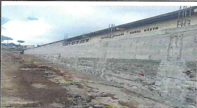
Foto 3 Muro de contención terminado
