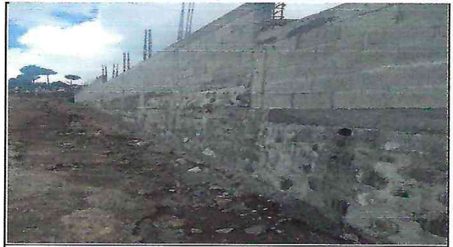
Foto 2 Muro de contención terminado
