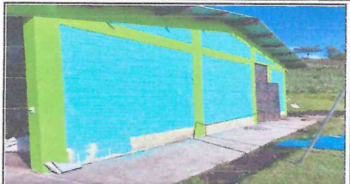
Proceso de pintada de muros interiores y exteriores de las aulas
