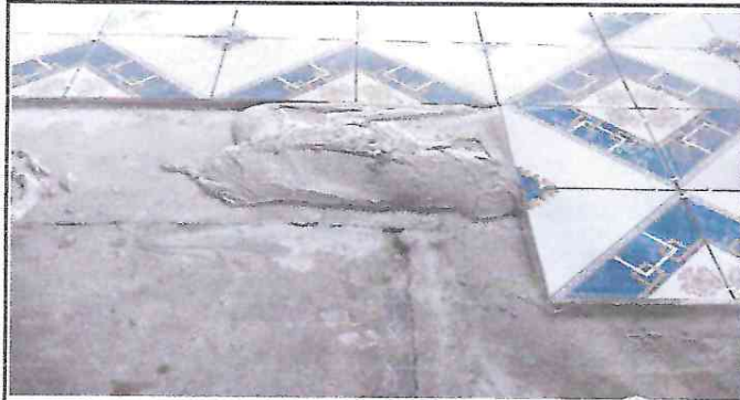
Colocación de azulejo
