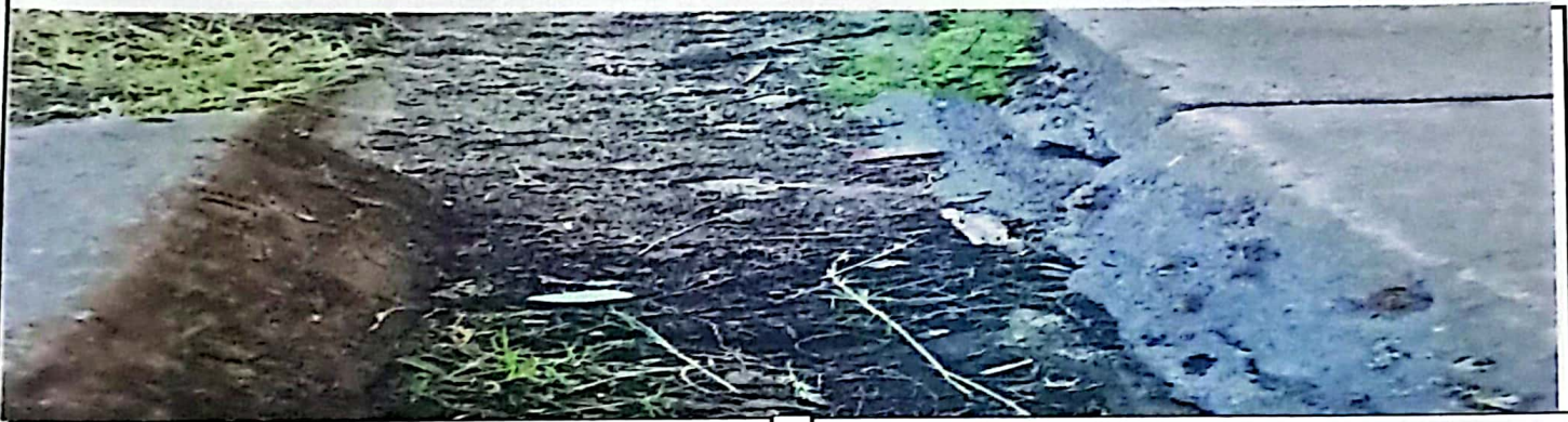
Foto 2: CUNETA DETERIORADA
