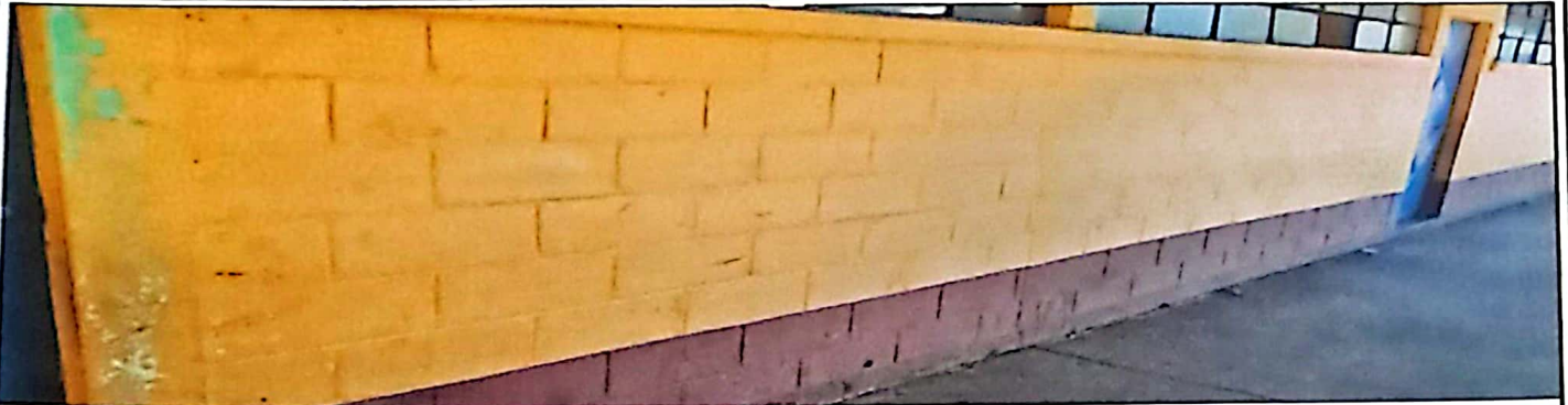
Foto 1: PINTURA DE PAREDES MANCHADAS Y DESCOLORIDAS
