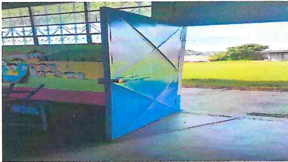
REPARACIÓN DE PUERTAS
