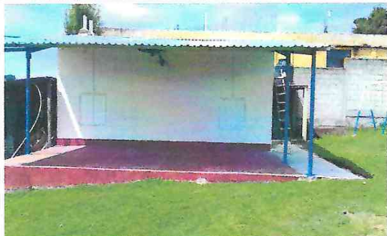
ESTRUCTURA DE TECHO
