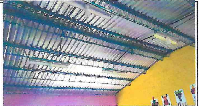
REPARACIÓN DE SISTEMA ELECTRICO
