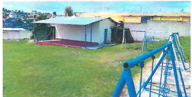
SUSTITUCIÓN DE LAMINAS
