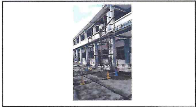
Foto 8: instalación de tubos para bajadas de agua pluvial.
