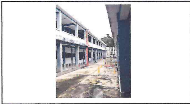
Foto 7: instalación de tubo
