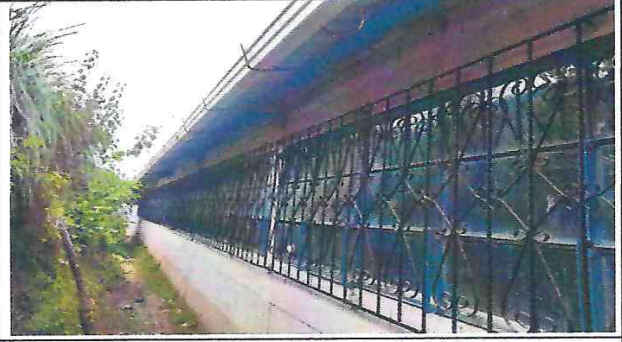
Foto 4: Canal de bajada de agua pluvial sustituido detrás de la escuela
