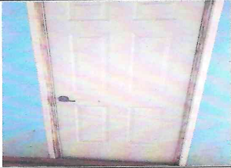
Foto 1: Chapa de la puerta de la cocina del lado norte sustituido
