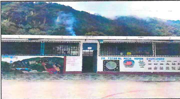
Foto 3: Canal de bajada de agua pluvial sustituido
