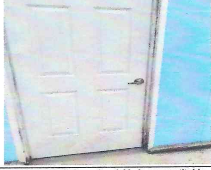
Foto 2: Chapa de la puerta de la cocina del lado sur sustituido
