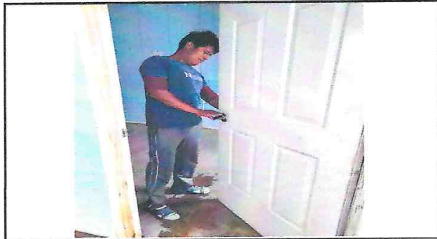
Foto 1: Sustitución de chapa de la puerta de la cocina del lado norte
