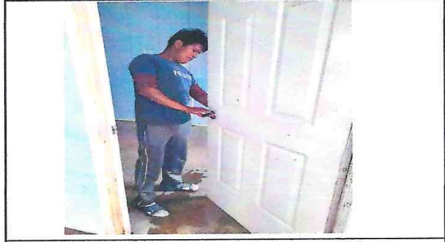
Foto 2: Sustitución de chapa de la puerta de la cocina del lado sur
