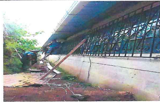
Foto 4: Sustitución y colocación de canales de bajada de agua pluvial detrás de la escuela
