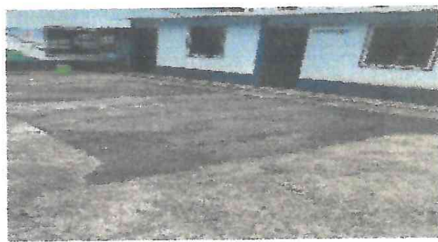
Foto 4: Cancha reparada a la perfección.
