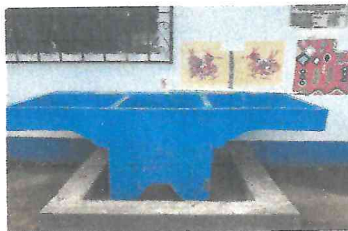
Foto 2: Pila colocada y en buena condición.
