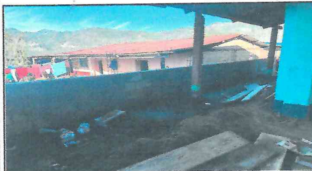
Colocación de block del muro
