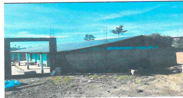
Terminación de columnas d la puerta
