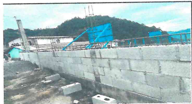
Armadura de hierro
