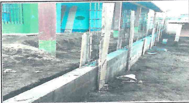
Muro a tras de la escuela
