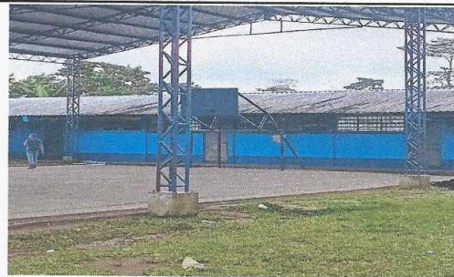
PINTURA DE MUROS EXTERIORES E INTERIORES DURANTE EL PROCESO DE MANTENIMIENTO
