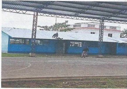
CUBIERTA DE LAMINA DURANTE EL CAMBIO
