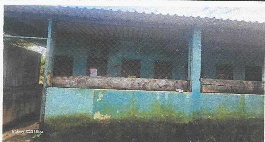
Foto 5: Sustrucción de balcones de metal de baño.
