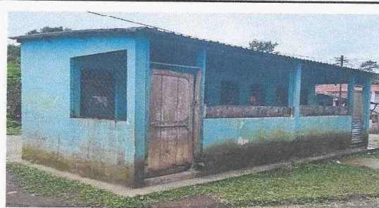
Foto 2: Mantenimiento a estructura de baño.
