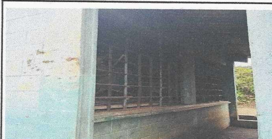
Foto 6: Mantenimiento a balcones de metal de cocina.
