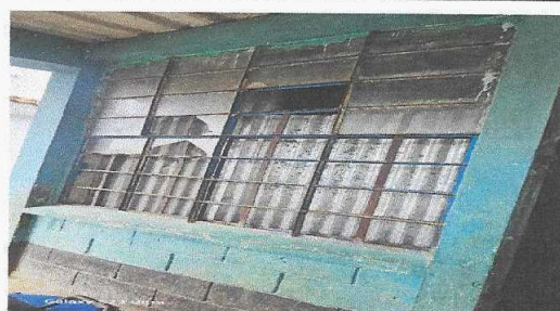
Foto 4: Sustrucción de estructura de metal de ventana de dirección.
