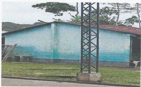
Foto 1: Sustrucción de lámina por lámina modulo uno de dos aulas.
