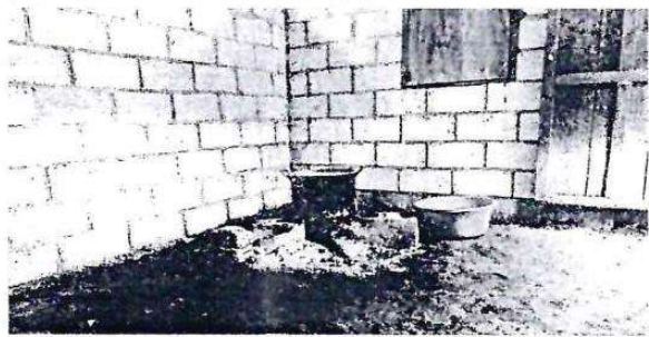
Foto 5: REPARACIÓN O SUSTITUCIÓN DE ÁREA DE COCINA
