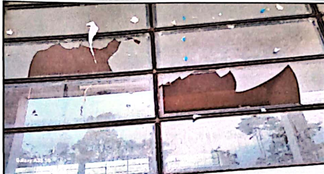
Foto 1: Reparación y cambio de Vidrios de Ventanas
