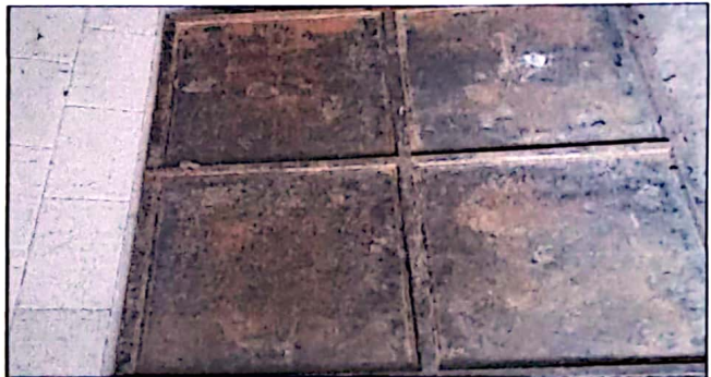
Foto 4: Limpieza y pintura de puertas
