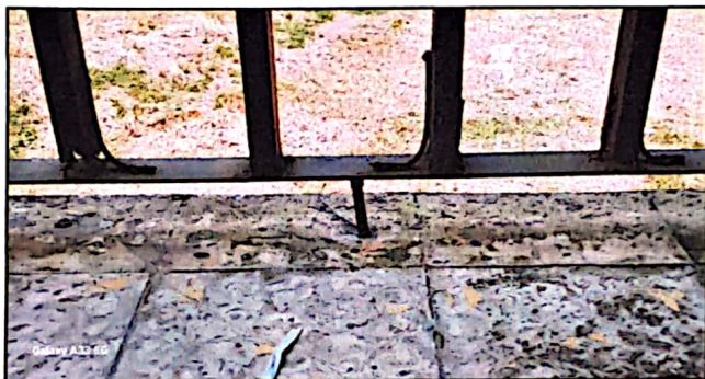
Foto 3: Cambio de Baranda de grados primero y segundo nivel
