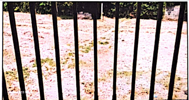
Foto 2: Limpieza y Pintura Baranda segundo nivel
