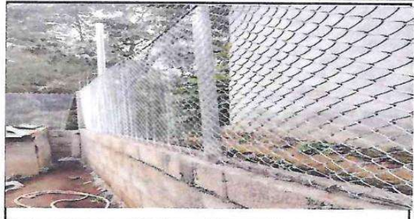
Foto 2. Cerco o Muro Perimetral
