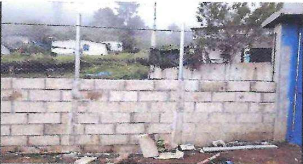
Foto 3. Cerco o Muro Perimetral
