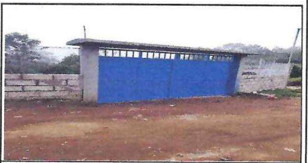
Foto 6. Mantenimiento a portones
