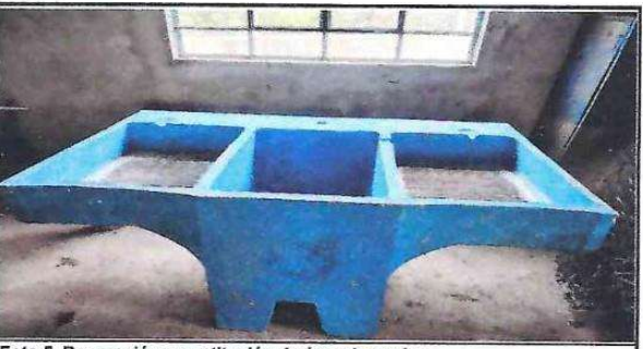
Foto 5. Reparación o sustitución de área de cocina
