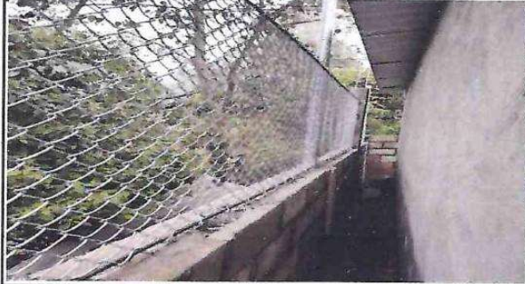
Foto 1. Cerco o Muro Perimetral
