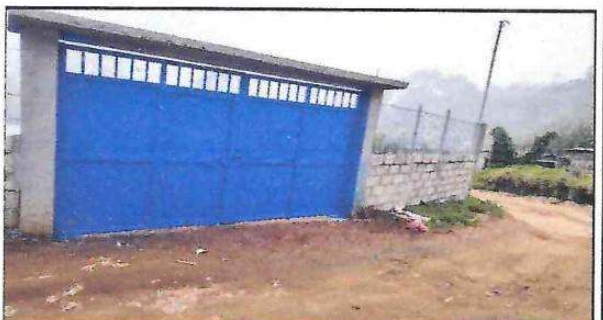
Foto 4. Cerco o Muro Perimetral
