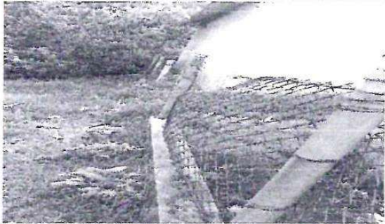
Foto 1. Cerco o Muro Perimetral
