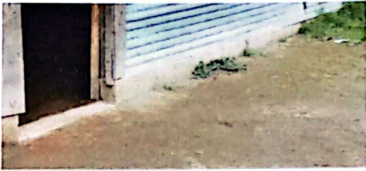
Cimiento de piedra y block completar con columna y pared de block
