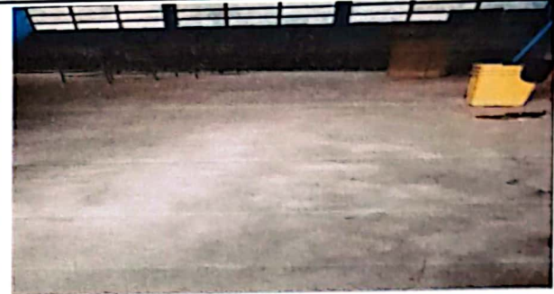
Foto 2: Instalar piso ceramico para facilitar la limpieza, con un area de 64 metros cuadrados
